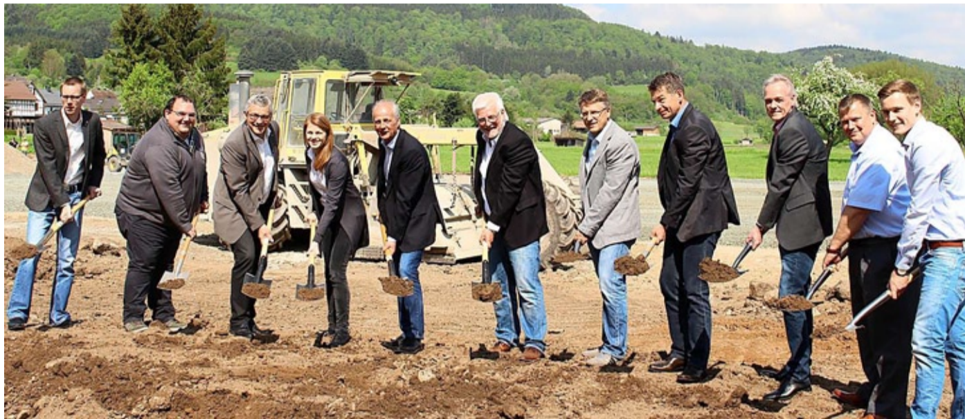
Vertreter von Roth Kunststofftechnik, der Roth Werke sowie der Planer und Baufirmen sowie Bürgermeister Bernd Schmidt beim Spatenstich für den Neubau in Wolfgruben. Foto: Roth Werke
