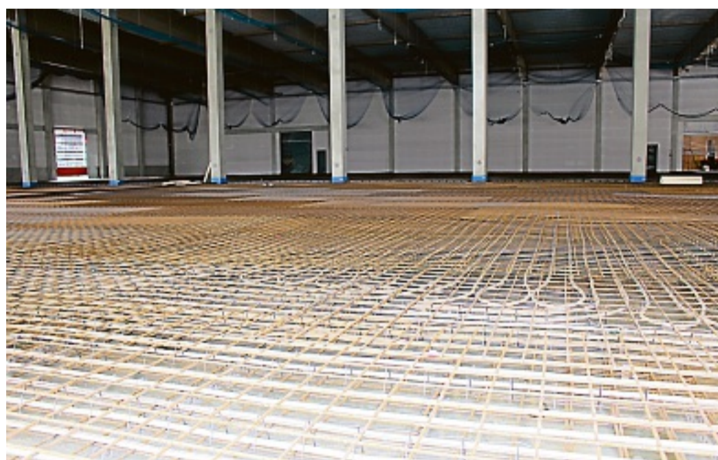
Im Boden der Halle wurden 29 Kilometer Rohre für eine Industrieflächenheizung aus dem Hause Roth verlegt, die für eisfreies Arbeiten sorgt.
